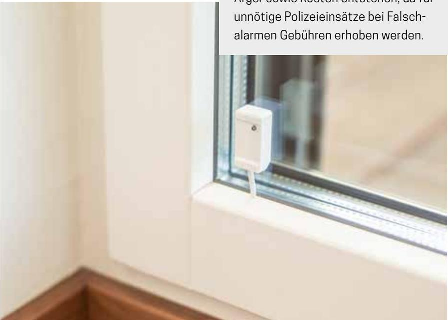
↪ Außenhautüberwachung mit einem Glasbruchmelder
